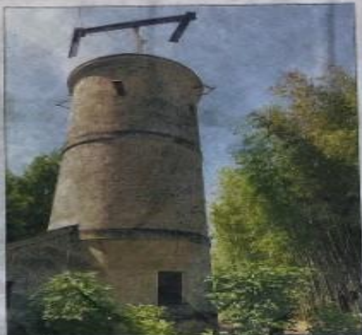
À 10 mètres de haut, les bras articulés forment des signaux codés.
